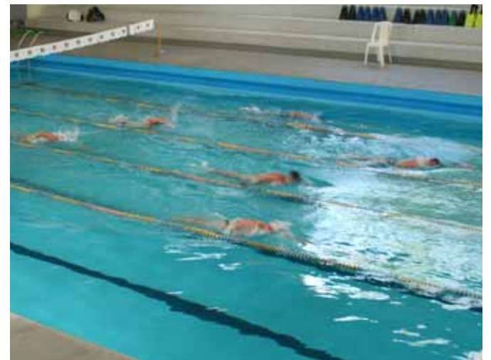
Piscina térmica de 25m de raia livre e hidroginástica
